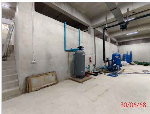
ถังเก็บน้ำชั้นใต้ดินและระบบสูบน้ำของโครงการ
